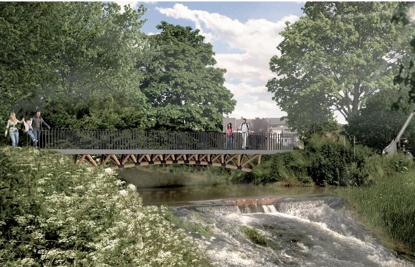
Mit Mitteln aus dem EU – Fonds für regionale Entwicklung (EFRE) wird die Umsetzung der stofflichen Verwertungen nachwachsender Rohstoffe ( Holz ) in einem praktischen Projekt unter dem Titel , \*Entwicklung eines Rundholz-Tragwerksystems (RTS) aus geschältem Rundholz mit Verbindungsknoten aus Sonderbeton zur Herstellung von Fachwerkbrücken in Holz-Beton-Verbundbauweise\* umgesetzt.
