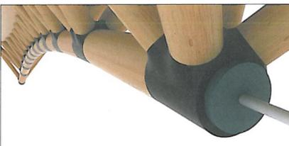
Dieses Bild zeigt die Untersicht der Brücke und den dort befindlichen Druckbogen aus Douglasienrundholz, an den Druckdiagonalen angeschlossen sind, die das Brückendeck tragen.
