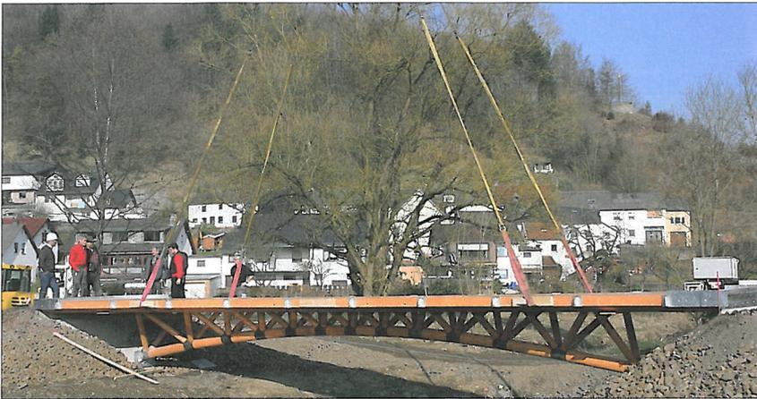
Holzbau Floss entwickelte mit dem Lehr- und Forschungsgebiet Holz der Hochschule Trier ein neues Tragwerksystem aus Rundholz – Das Ergebnis: Eine neue Brücke für die Gemeinde, welche die Ortsteile Schönecken und Wetteldorf verbindet.
